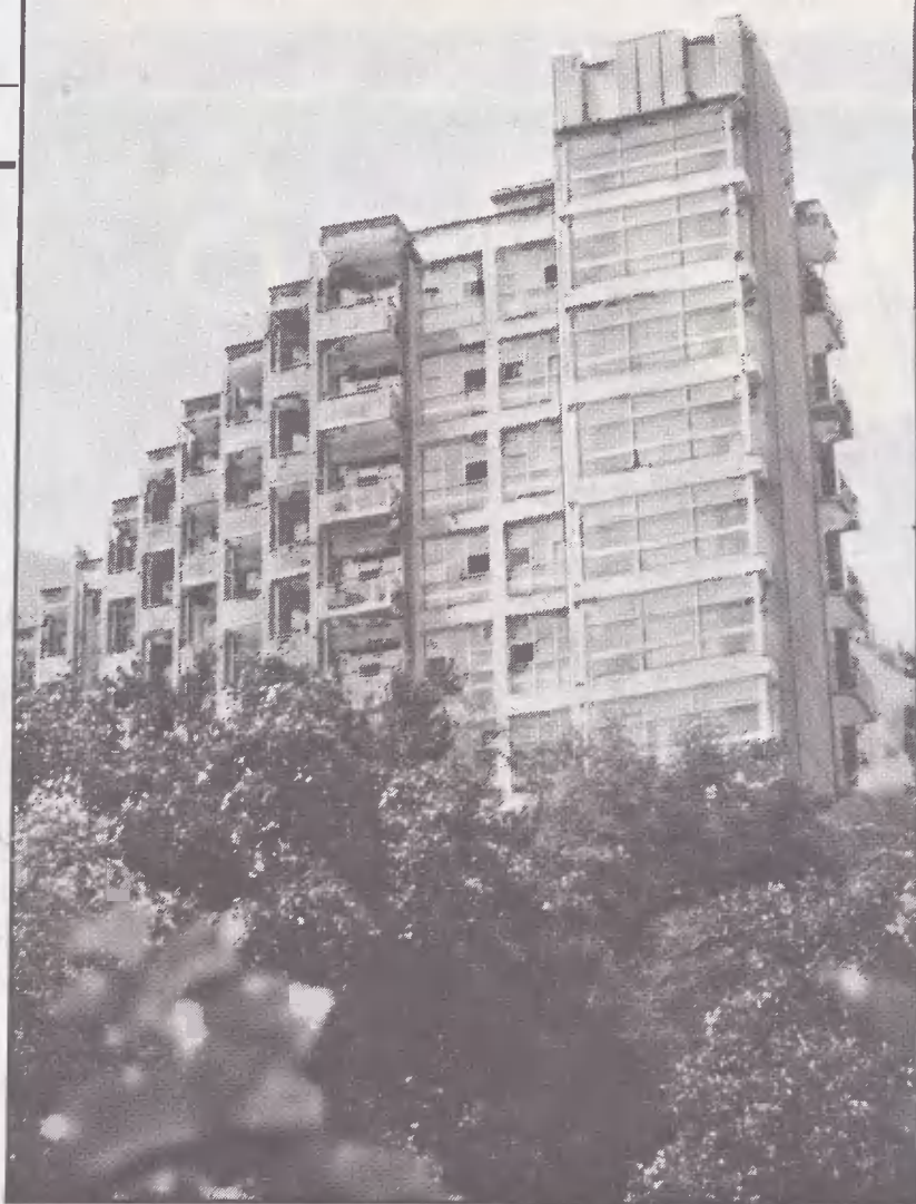
Корпус санатория «Ходжа-Обигарм». Таджикская ССР.
