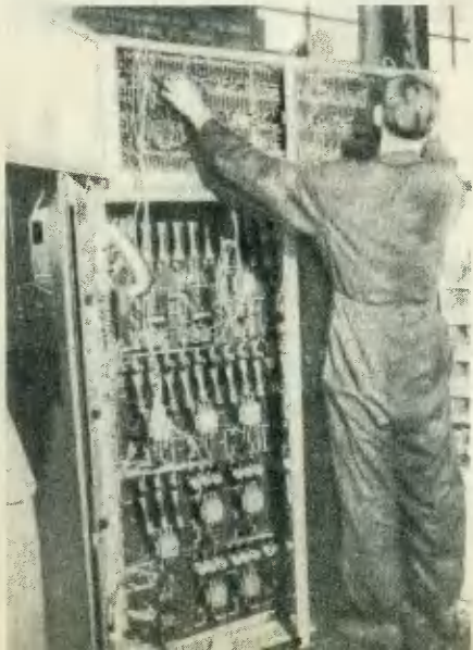
Приборный шкаф — «мозг» автоматической линии.
