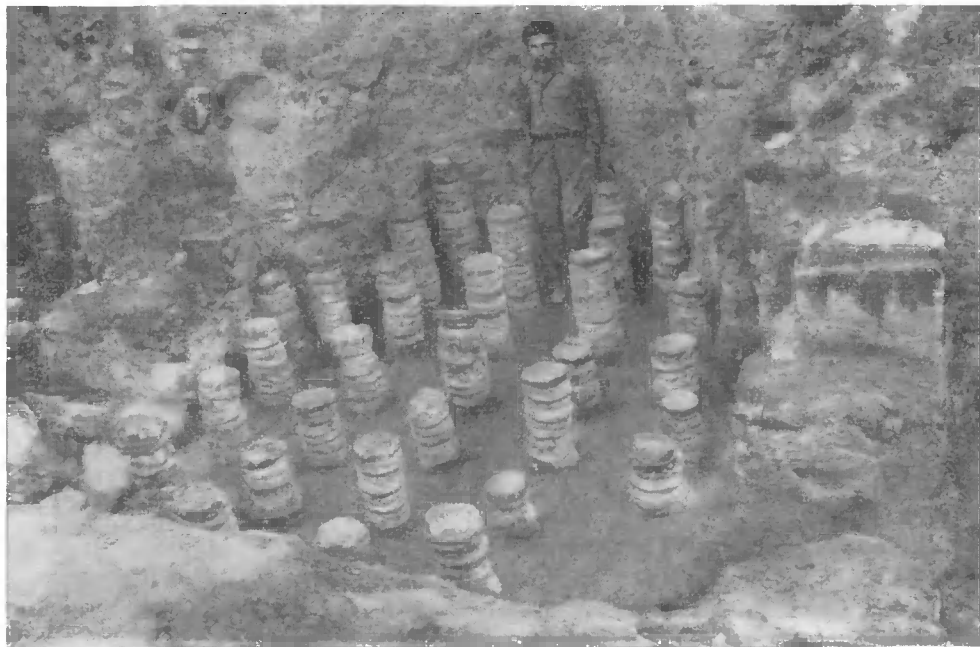
Рис. 4. Стойки на нижнем полу бани
