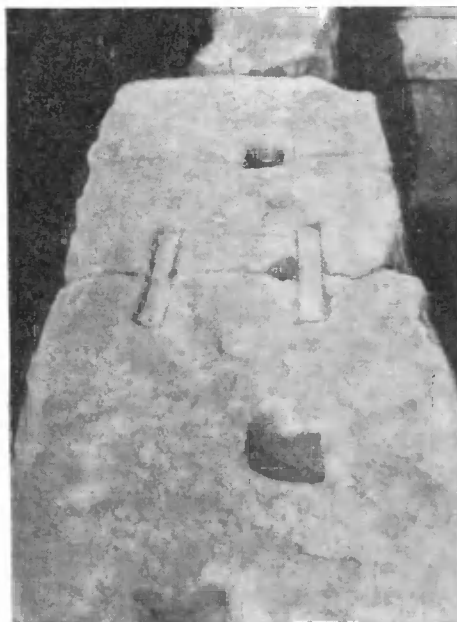
Рис. 4. Деталь кладки южной стены с металлическими скобами
