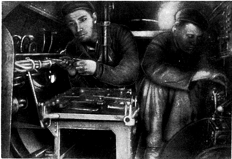
Рис. 1. Выполнение монтажных работ в условиях нечлененной кабины летчика
