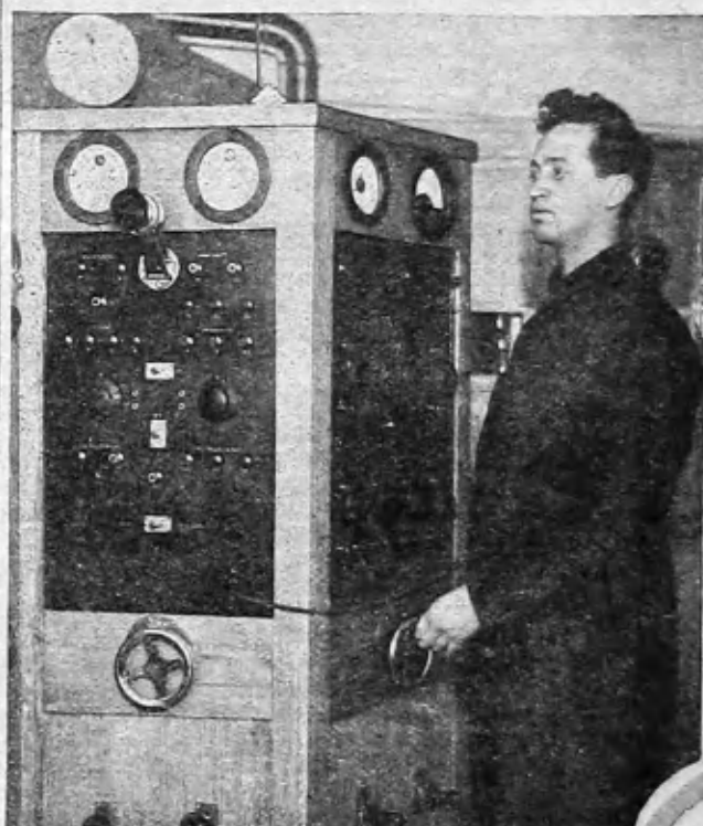
Мощный транслюционный усилитель Учкярофсжа Сев. жел. дор. По линии ж. д. до ст. Пушкино (50 километров) радиофицированы все красные вагоны, клубы, помещения дежурных и др. Расположенная по пути дер. Шаравовка также радиофицирована. Всего установлено 300 громкоговорителей.
