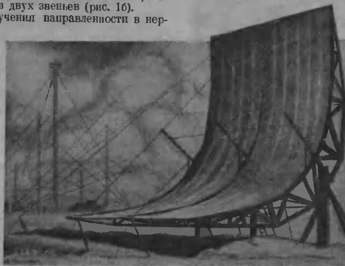
Рис. 3. Устройство Мейснера для направленной радиопередачи.
