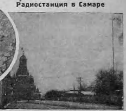
Направо—общий вид антенны (подвешена на мачте и на колокольне собора)
