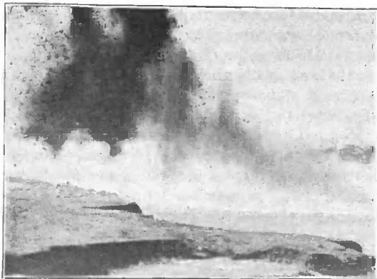
Рис. 2. Моментъ перваго соединенія водъ Атлантическаго и Тихаго океановъ. При прорытіи канала послѣдній барьеръ у вершины Басъ-Обиспо былъ взорванъ зарядомъ динамита, вѣсомъ въ 20 тоннъ.
