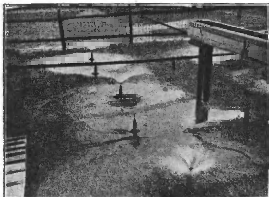
Рис. 11. Поверхность окислителя на биологической станціи московскихъ полей орошенія. Вокругъ разбрызгивателей, приблизительно на периферіи обслуживаемаго каждымъ изъ нихъ района, виденъ валикъ. Послѣдній образованъ массою личинокъ мухъ (по Никитинскому).
