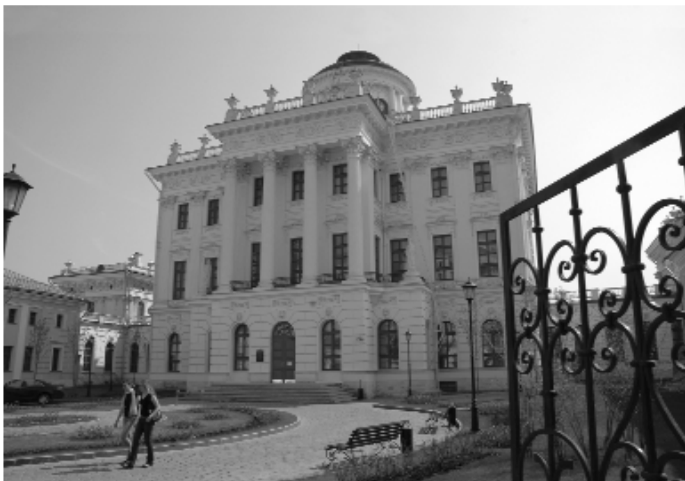
Дом Пашкова со стороны Староваганьковского переуллка (после реконструкции)
