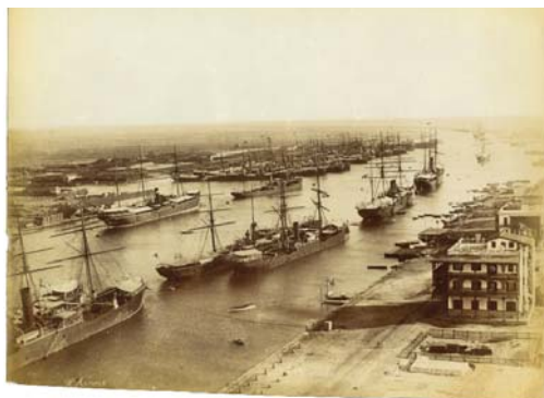
Суэцкий канал вскоре после открытия в 1869 г.
