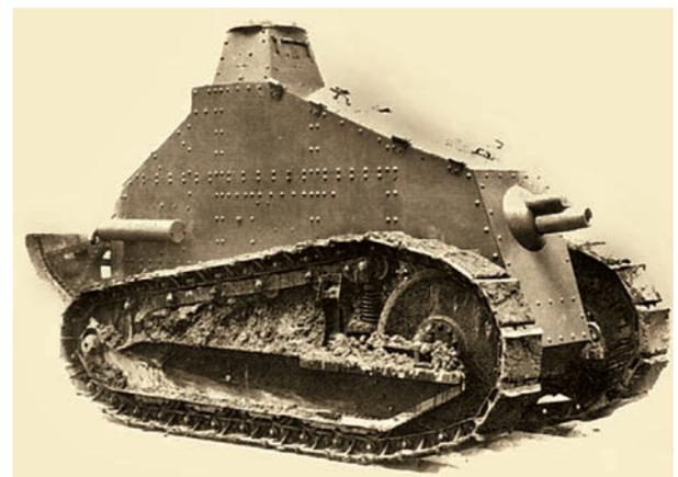
Прототип артиллерийского танка BS, вооруженного 75-мм пушкой на шасси танка FT-17
