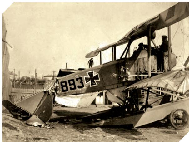
Разбитый Румплер 6B1 первой серии — шасси и кабина пилота в ней остались целы при таких повреждениях крыла и фюзеляжа. Фото: <http://seawarpeace.ru...>
