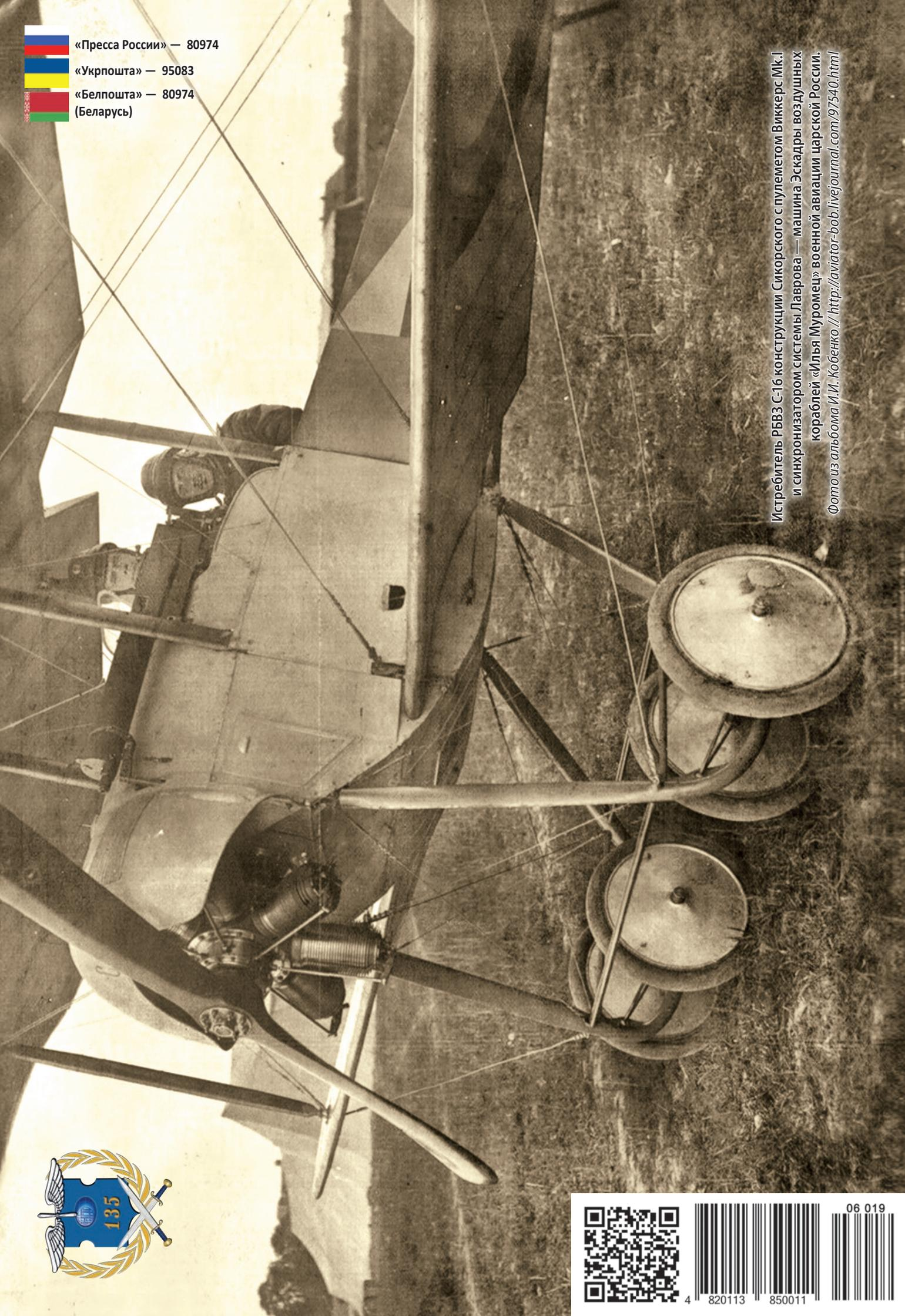
Истребитель РВВЗ С-16 конструкции Сикорского с пулеметом Виккерс (Мк.1) и синхронизатором системы Лаврова — машина Эскадры воздушных кораблей «Илья Муромец» военной авиации царской России.
