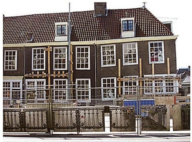
Рис. 11. Повреждения и закрепление фасада зданий при строительстве метро:
