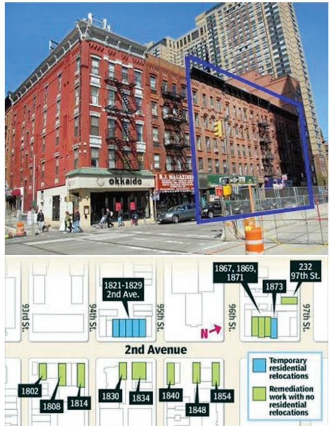
Рис. 5. Вверху: здание 2-й авеню № 1821–1829, претерпевшее наибольший ущерб от работ по строительству метро (в синей рамке). Внизу: голубым отмечены дома, из которых жильцы были временно эвакуированы, желтым — дома, которые потребовали ремонта. Источник: <http://thelaunchbox.blogspot.com/2010/03/march-27-2010.html>
