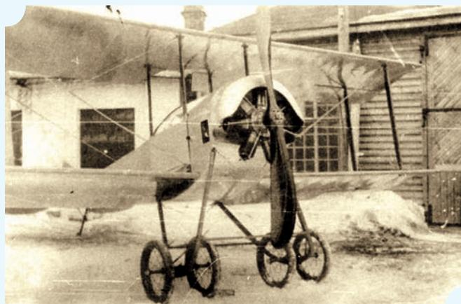
Второй опытный С-16 № 155, на котором в ходе строевой эксплуатации поставили семицилиндровый мотор Гном «Моносуап-А» мощностью 80 л. с. Фото: <http://www.airwar.ru/enc/fwv1/s16.html>
