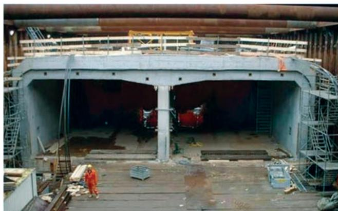
Рис. 17. Строительство погружного туннеля.
