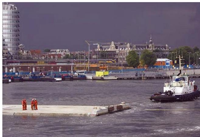
Рис. 18. Буксировка погружного туннеля к месту установки.
