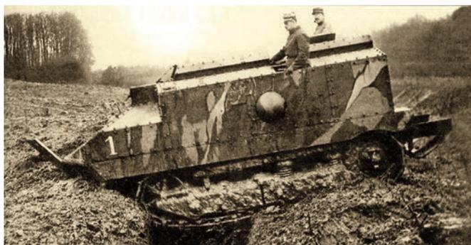
Один из первых серийных танков «Шнейдер» преодолевает канаву
