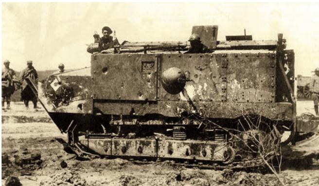
Модернизированный танк «Шнейдер». На бортах видны листы дополнительного бронирования
