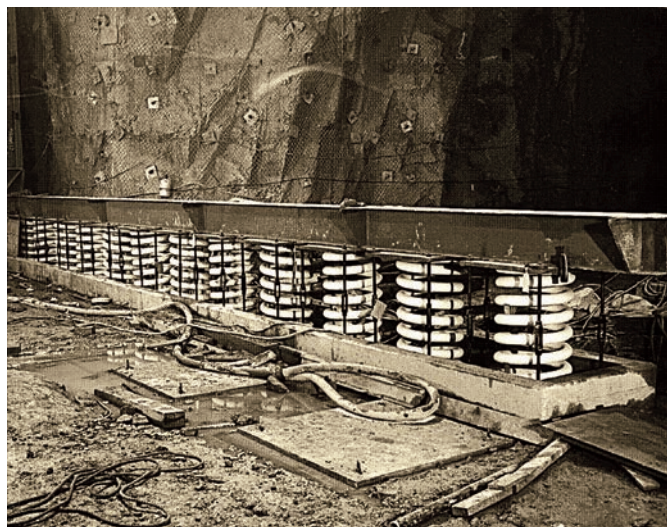
Рис. 11. Строительство удароустойчивого туннеля комплекса NORAD. Источник: https://commons.wikimedia.org/wiki/File:Cheyenne_Mountain_Const_-_Interior_-_Springs...
