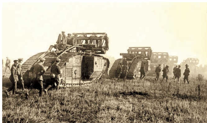
Колонна танков MkV с укрепленными на крыше фашинами для преодоления рвов. Франция, 1918 г.
