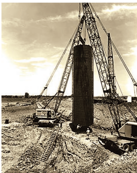
Рис. 32. Испытания шнекового бурения ракетного силоса в Аляске: проектные размеры силоса — диаметр 4,5 м, глубина 22,5 м. Источник: https://www.boeing.com/news/frontiers/archive/2002/november/i_ids4.html
