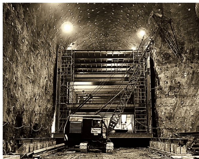
Рис. 9. Мобильный кран в строящейся полости комплекса NORAD. Источник: https://commons.wikimedia.org/wiki/File:Cheyenne_Mountain_Const_-_Crane_in_tunnel.jpg
