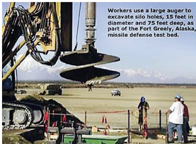
Рис. 32. Испытания шнекового бурения ракетного силоса в Аляске: проектные размеры силоса — диаметр 4,5 м, глубина 22,5 м. Источник: https://www.boeing.com/news/frontiers/archive/2002/november/i_ids4.html
