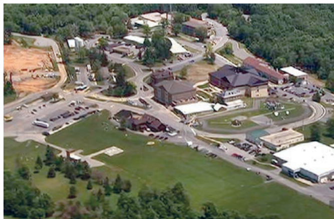
Рис. 4. Наземные постройки комплекса Маунт Вевер. Источник: https://www.nbcwashington.com/news/local/Mt_Weather_Secret-Govt_Facility...
