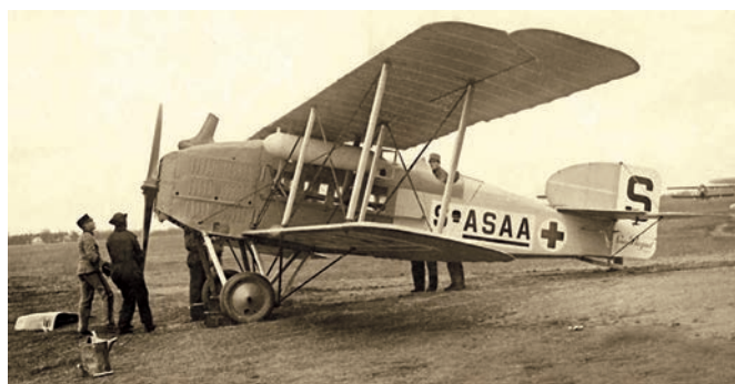
Санитарная модификация самолета Breguet Br.14 — Br.14S
