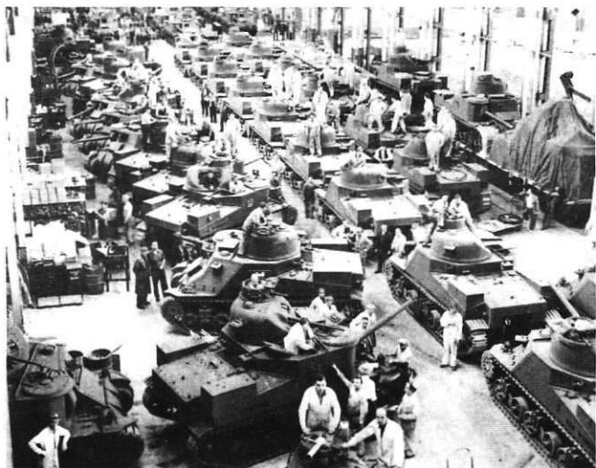
**Линия сборки танков М-3**
