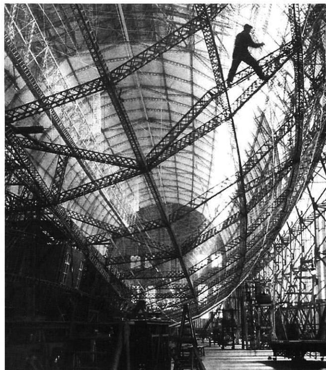
**Дирижабль "Граф Цеппелин" имел жесткую конструкцию из алюминиевого каркаса, обшитого тканью, внутри которого располагались баллонеты с водородом**
