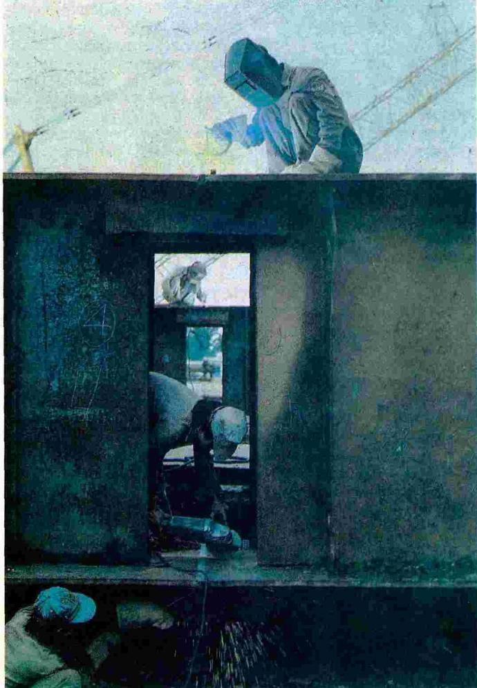
Сборка несущего модуля платформы
