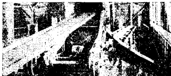
Рис. 5. Сбрасывающая тележка Э. на ст. Богатое, Ташк. ж. д. 1 — ось верхнего вала тележки; 2 — ось нижнего вала тележки; 3 — патрубок тележки для отвода зерна; 4 — приставная труба для направления зерна в силосом; 5 — рама стальной тележки; 6 — колеса тележки; 7 — направляющие бруссы (рельсы для тележки) стальной транспортера; 8 — груз тормозного приспособления при остановке тележки.
