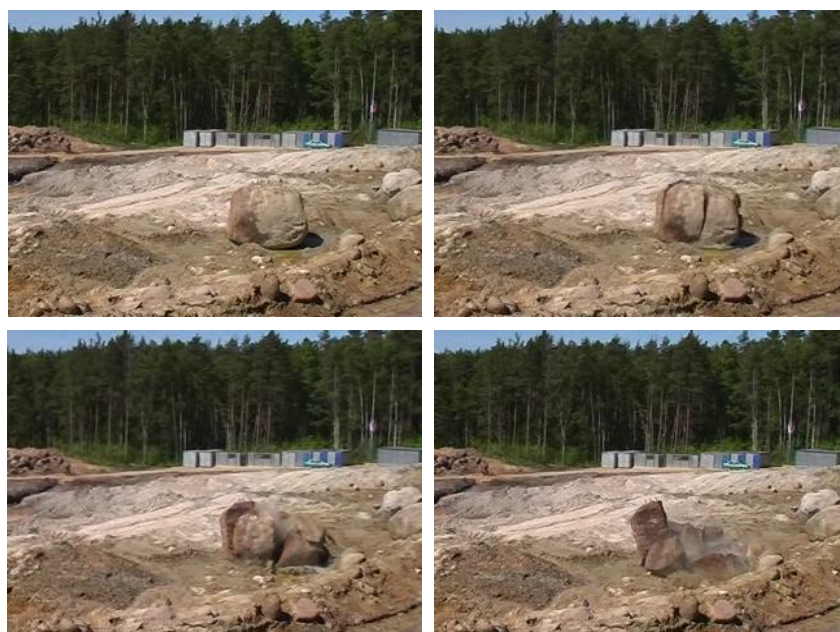
Рис.6. Последовательность дробления валунов газогенераторами при строительстве нефтяного терминала
