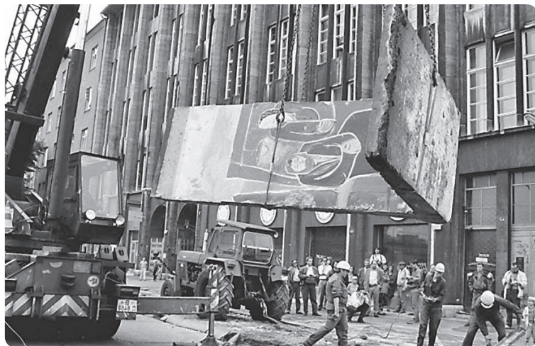
Демонтаж Берлинской стены
