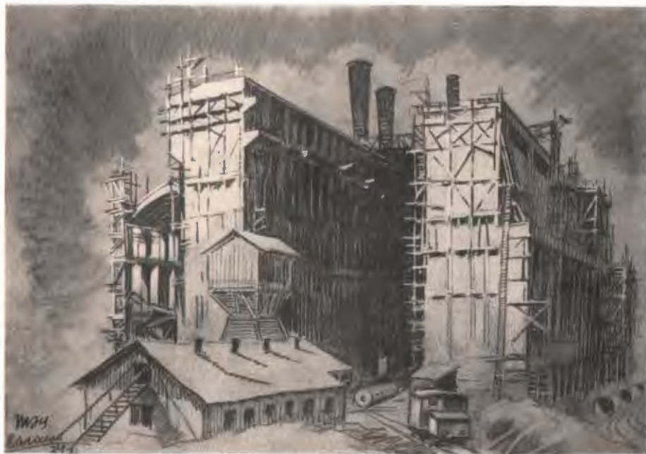
Уралвагонзавод. Строительство ТЭЦ. 1934
