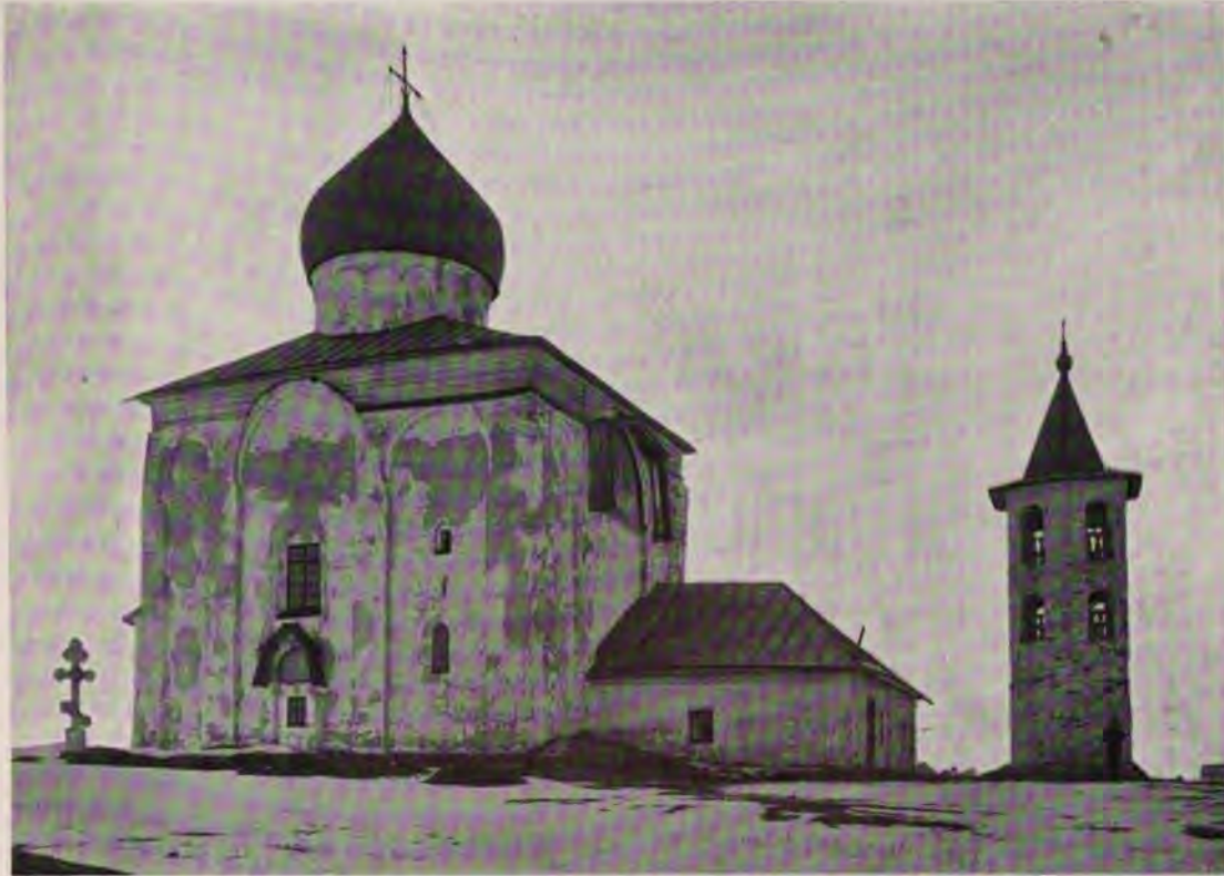
Съверный фасадъ до ремонта (мартъ 1903).
