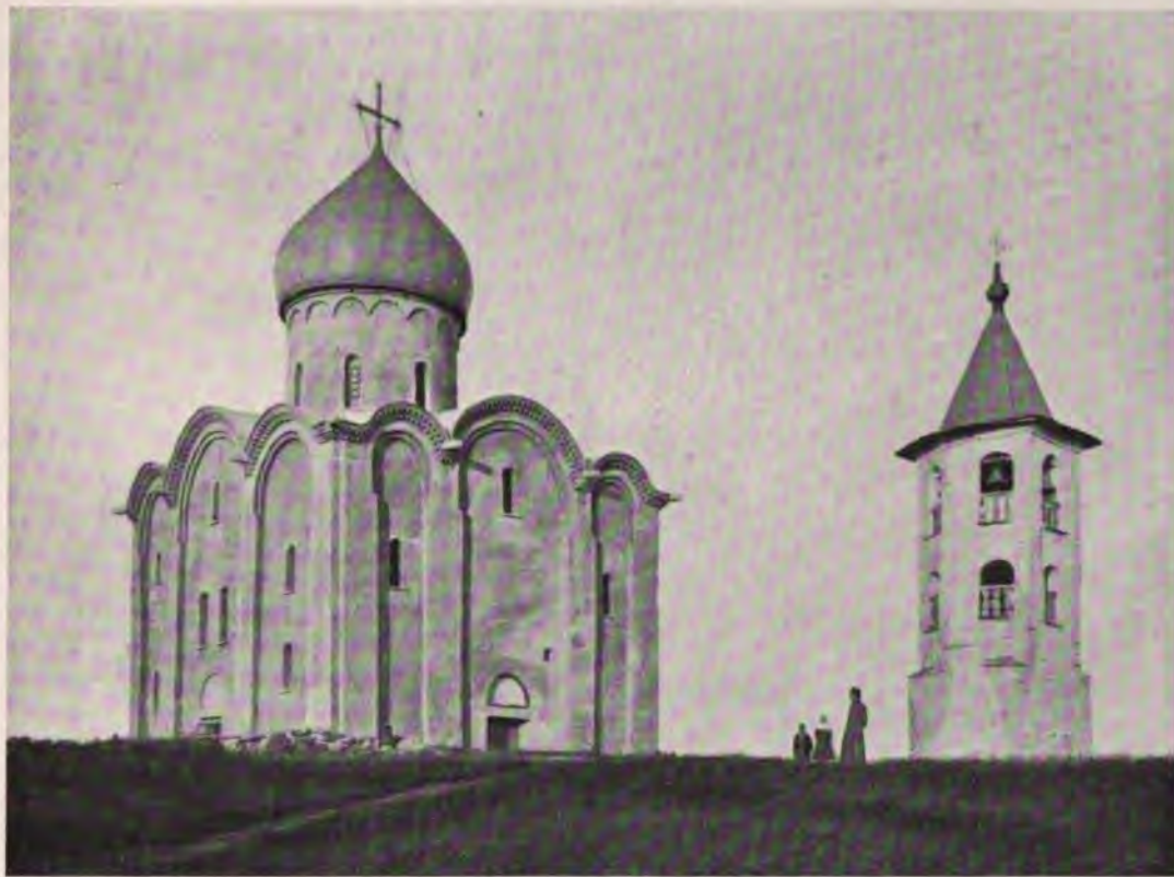
Видъ съ сѣверо-западной стороны послѣ ремонта.
