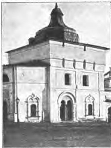
Рис. 70. Ярославль. Богородская башня, 1623 г.
