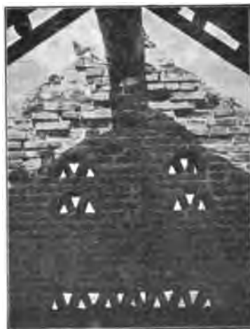
Рис. 64. Деталь шпигца ввнутри.
