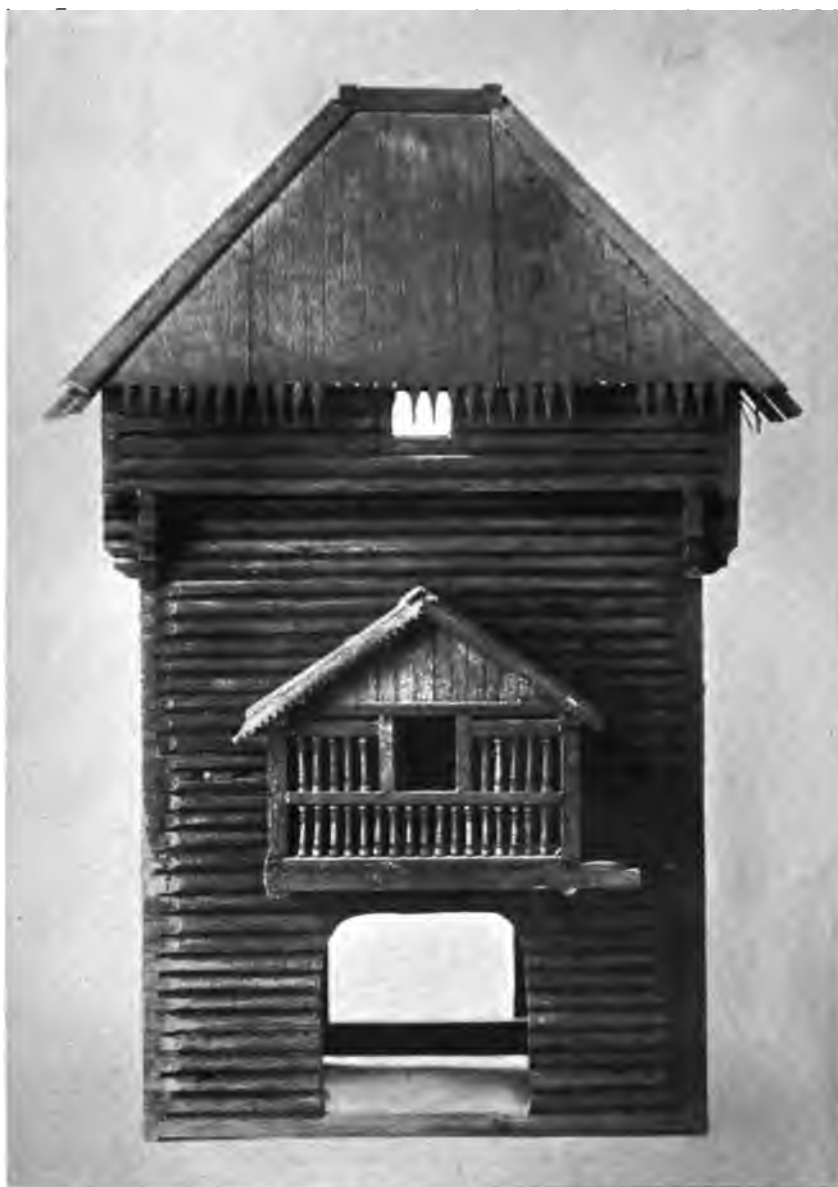
Отдельная, восточная башня Якутского острога. Фасадъ внутренней, западной стороны.
