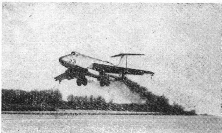
Фиг. 97. Взлет самолета Мартин XB-51 со стартовым пороховым ускорителем.
