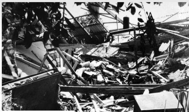
Остатки дома на улице Энергетиков
