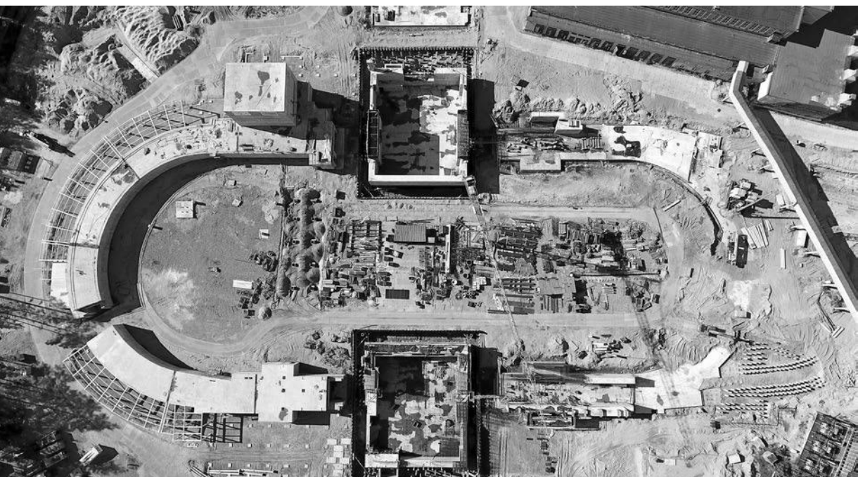
Так выглядит с высоты птичьего полета строительная площадка сверхпроводящего коллайдера NICA — уникального в мировом масштабе инженерно-научного сооружения
