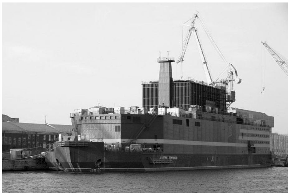
ПАТЭС (плавучая атомная электростанция)
