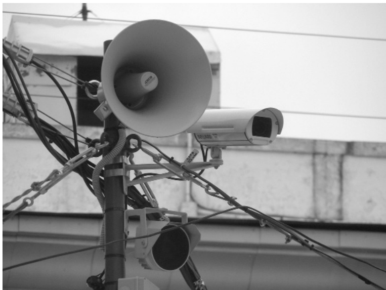
Внизу – инфракрасный прожектор, чтобы камера видела и в темноте
