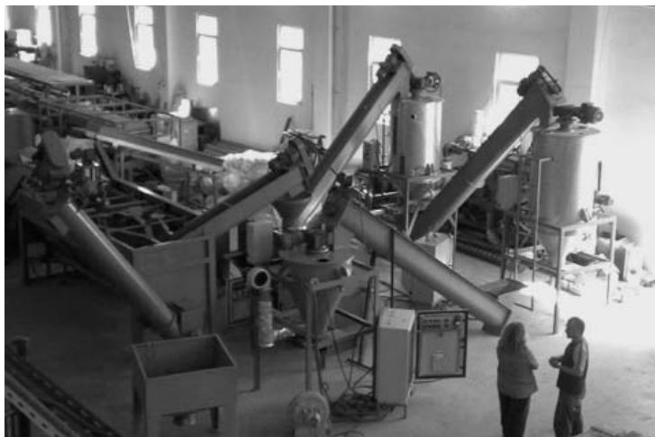
Оборудование для переработки полимерных отходов
