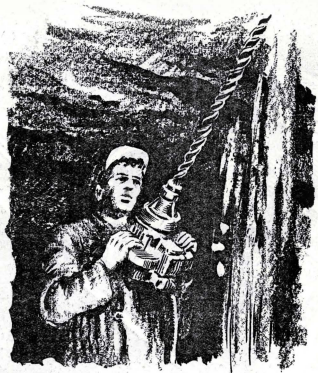
В Соликамской соляной шахте широко применяются электросверла и другие механизмы, облегчающие труд горняков.
