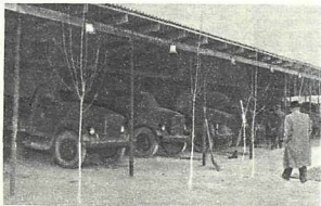
В Андижанской области развернулось строительство комплекса сооружений для учебных организаций ДОСААФ. На снимке: крытые стоянки автомобилей областного АМК.
