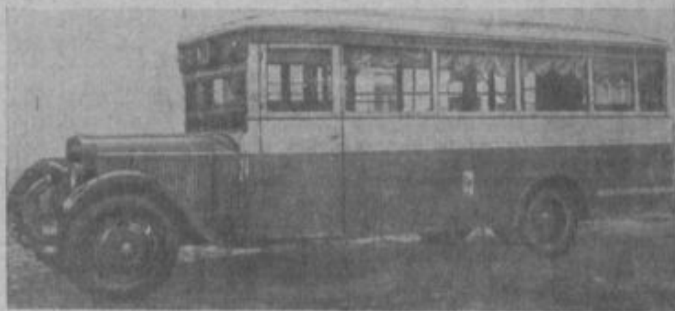
Кузов автобуса ЗИС-8, изготовленный мастерской Тульского горкомхоза
