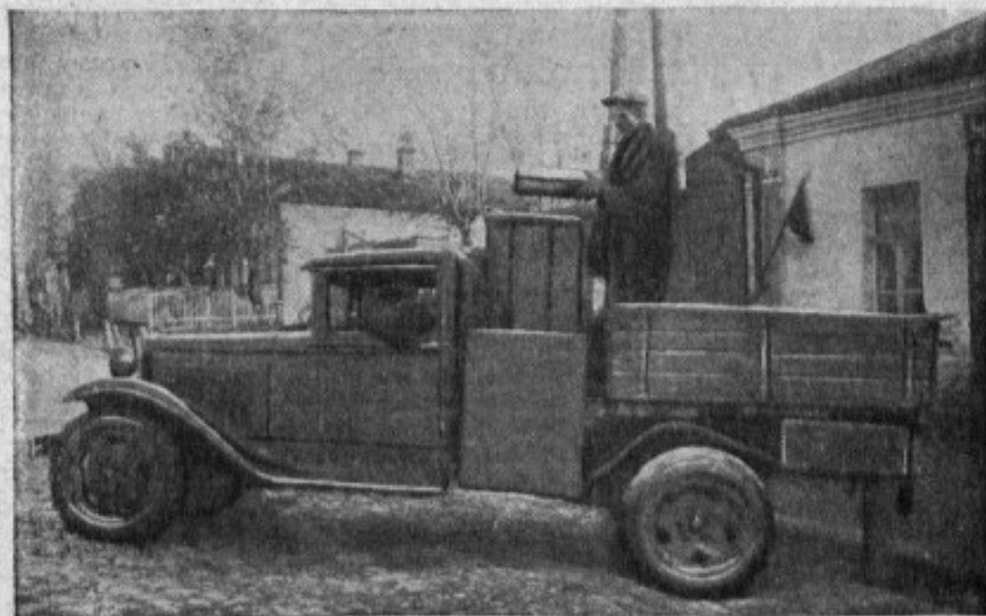
Рис. 1. Автомобиль ГАЗ-АА с газогенератором Кузнецова, работающем на полуметровых дровах
