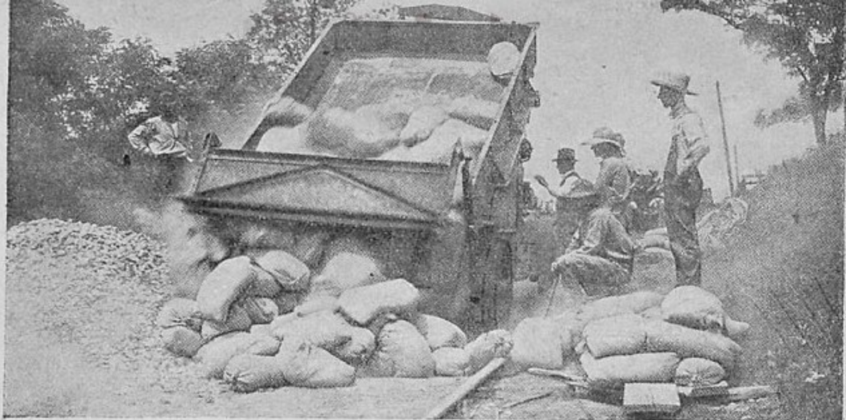
Применение автотранспорта ускоряет и удешевляет строительство. На снимке — выгрузка мешков со строительным материалом на американской постройке
