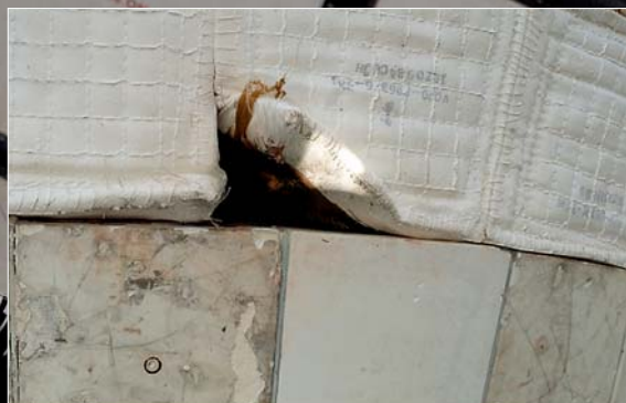
Повреждение теплозащиты до ремонта (15 июня).
