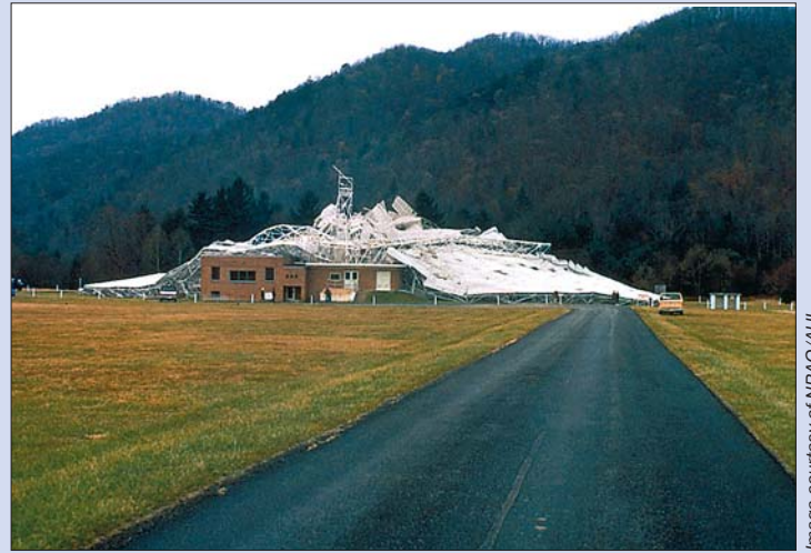
В среду 15 ноября 1988 года в 21:43 EST 300-футовый (92 м) телескоп в Грин Бэнк разрушился. Причиной этой трагической аварии послужил отказ одного из главных несущих элементов монтировки антенны. Эти фотографии были сделаны 15 и 16 ноября, до и после аварии.
