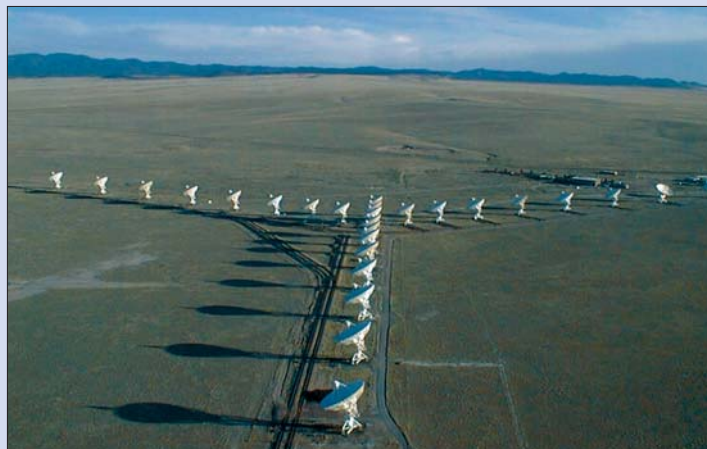
Антенны системы апертурного синтеза VLA (Socorro, New Mexico, USA), состоящей из 27 антенн диаметром 25 м. Максимальная длина базы 35 км позволяет получить угловое разрешение 0,04'' на волне \lambda = 1,3 см.
