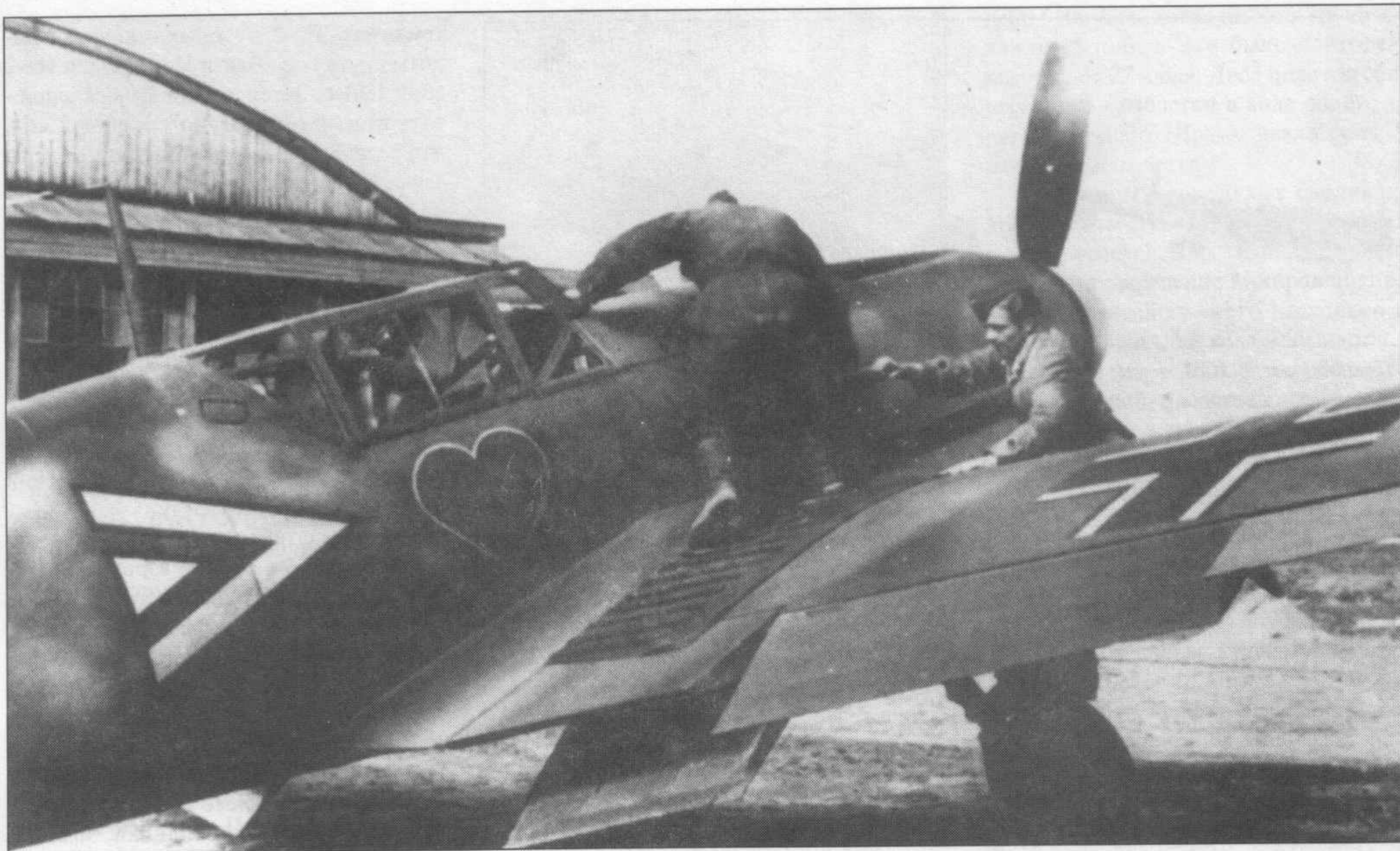
Me 109F командира одной из групп JG 54, 1942 год. В отличие от большинства «Фридрихов» у этой машины передние углы фонаря остеклены.
