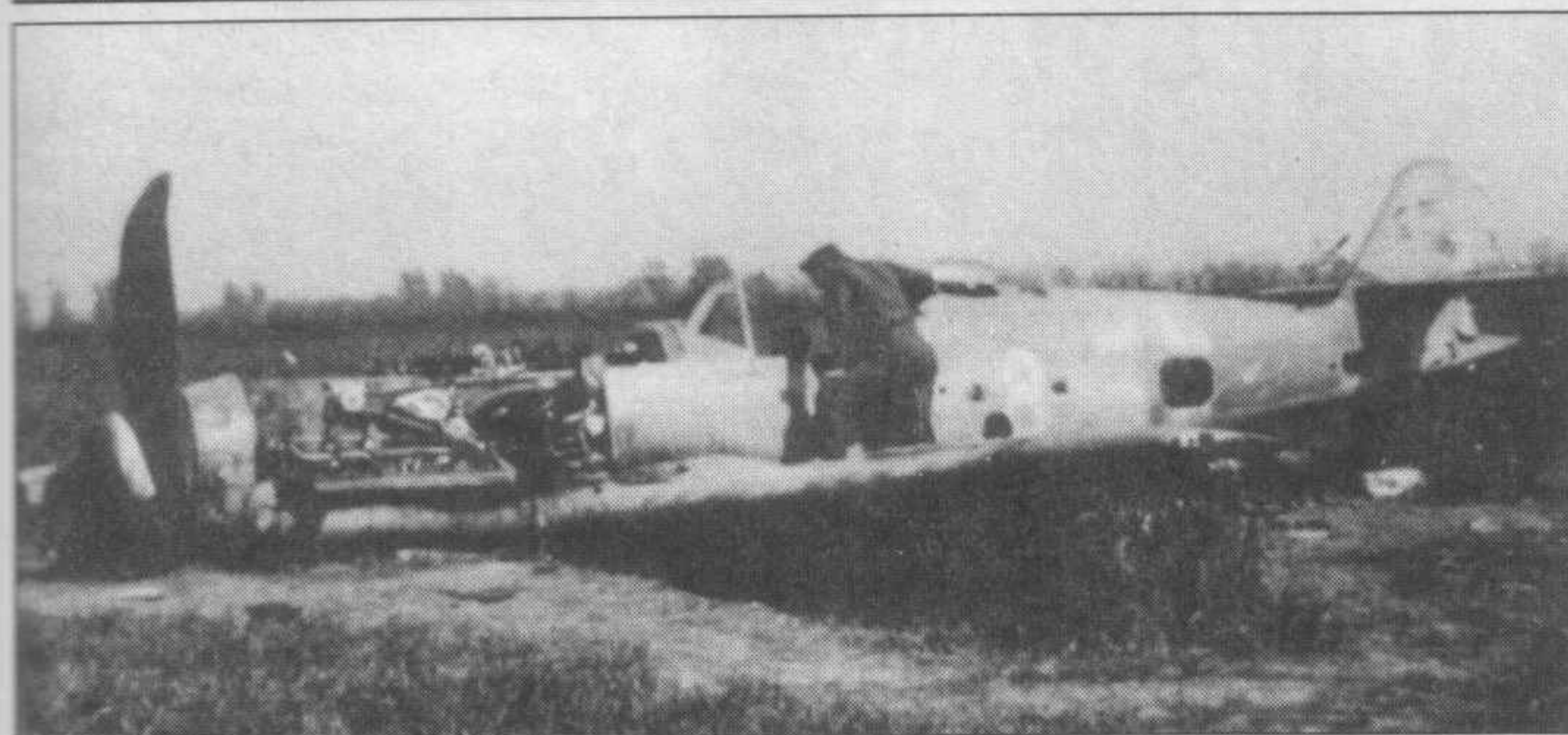
Два снимка Me 109G-14, сбитого американцами где-то на западе. «Густавы-14» с серийным номером, начинающимся на 46, выпускались заводом Erla. «Белая 7» на руле направления вероятно использовалась на время доставки самолетов в части. Темная полоса за крестом не полоса быстрой идентификации, а следы замазанного тактического знака.
