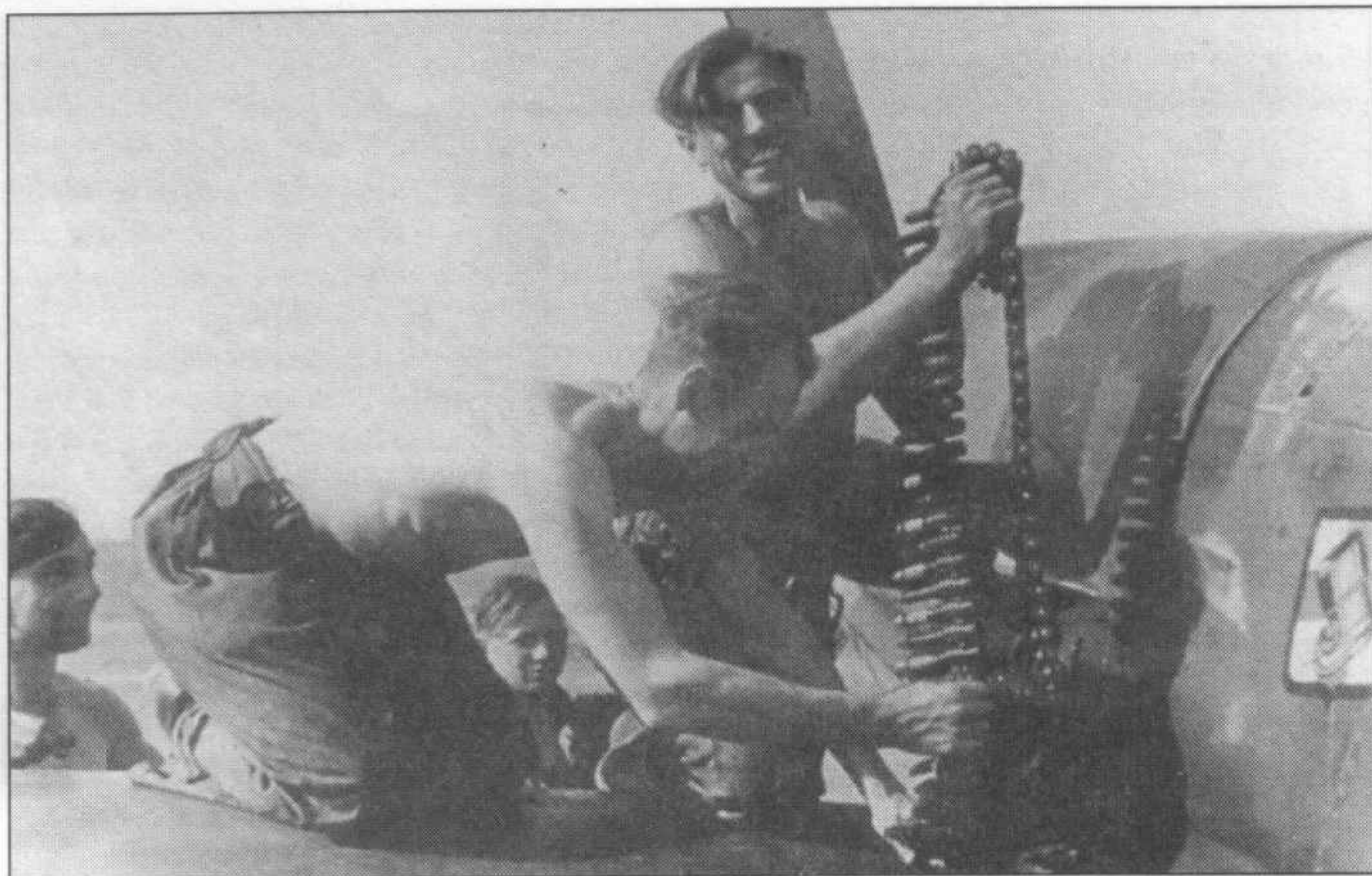
Зарядка пушки MG 151/20 на Me 109F-4. Это было нелегким делом. На фюзеляже самолета видна эмблема III./JG 5, нанесенная поверх эмблемы эскадрильи.
