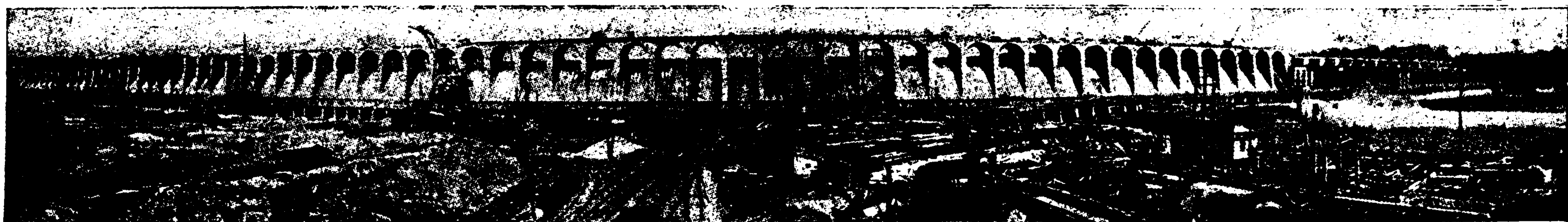
„Новая Ниагара Юга С.-А. С. Штатов“ — Вильсоновская плотина на реке Теннесси, приводящая в движение турбины мощностью в 600,000 лош. сил.
