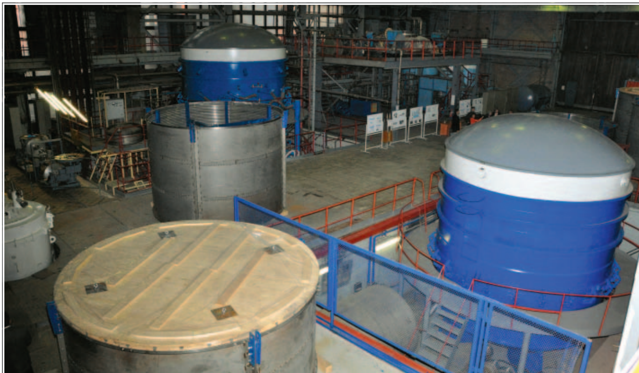
Криостат для гидравлических и вакуумных испытаний токонесящих элементов ITER в НИЦ «Курчатовский институт»
