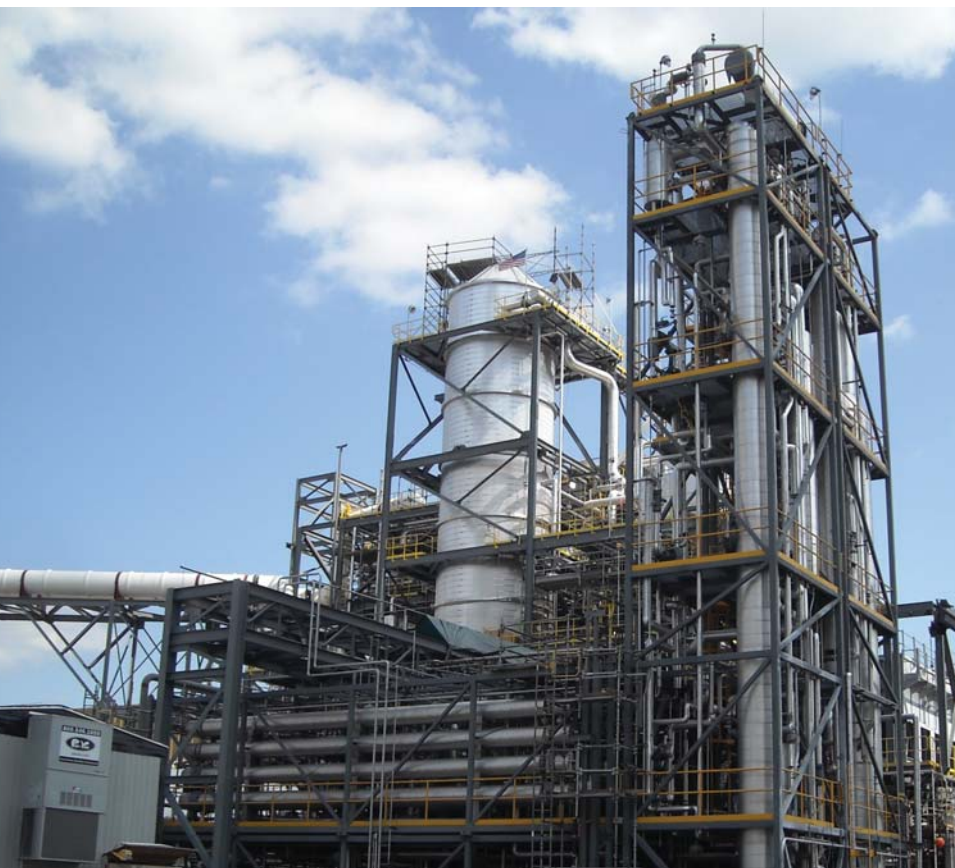
УСТАНОВКА ПО УЛАВЛИВАНИЮ УГЛЕРОДА на электростанции Mountaineer близ Нью-Хейвена, Западная Виргиния. Для улавливания диоксида углерода, образующегося при сжигании угля, используются газоочистители с охлажденным аммиаком
