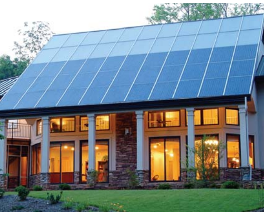
Солнечные батареи на крыше здания.
