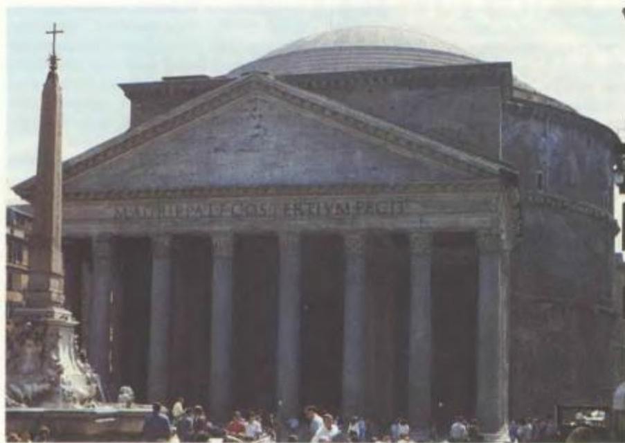
РИМСКИЙ ПАНТЕОН — одно из зданий, конструкцию которых изучал Филиппо ди Сер Брунеллески, архитектор, спроектировавший купол собора Санта-Мария дель Фьоре. Пантеон имеет полусферический купол, в вершине которого находится окно — единственный источник естественного освещения интерьера.
