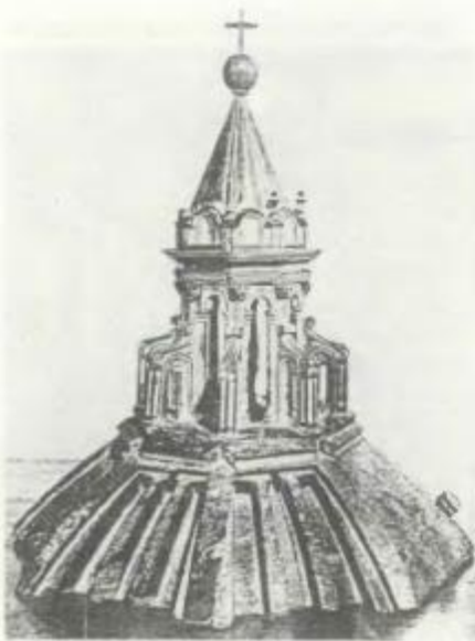
МАКЕТ ФОНАРЯ, спроектированный Брунеллески. Вес фонаря передается восемью ребрами купола, что повышает устойчивость всей конструкции.
