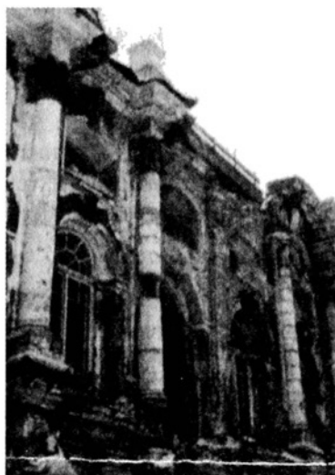
Разрушенный Екатерининский дворец после фашистской оккупации
