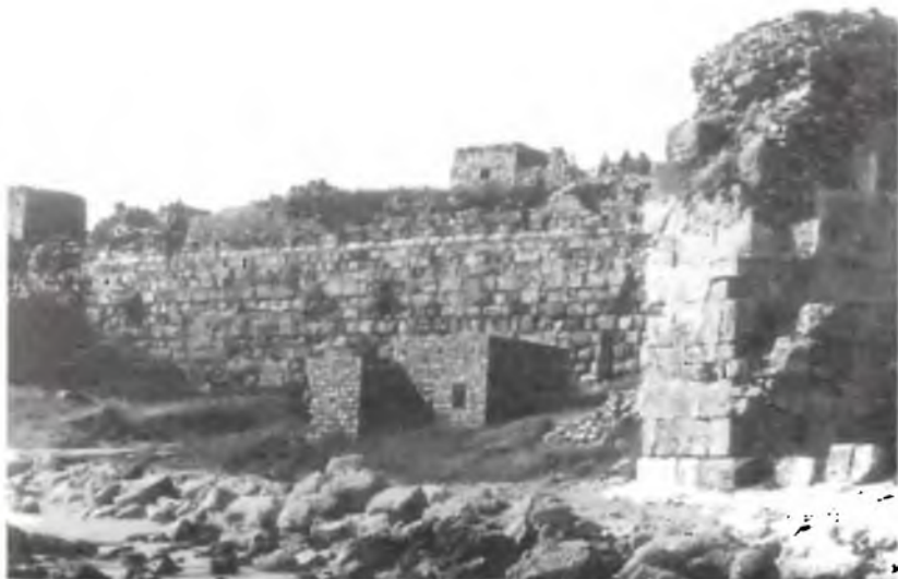
13. Часть морской стены замка Афлит в Палестине. Замок, построенный тамплиерами в 1218 г., был покинут в 1291 г. после падения Акра.
