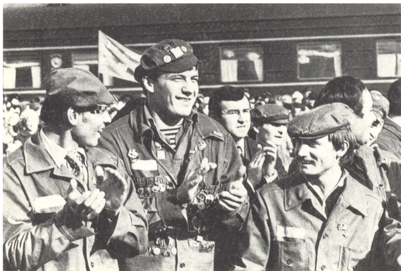
1974 год. На строительство БАМа прибыл первый Всесоюзный ударный комсомольский отряд
