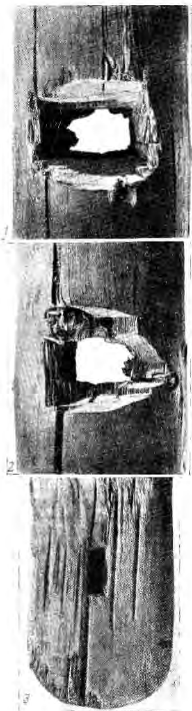
Рис. 3. Вырубка гнезд.
