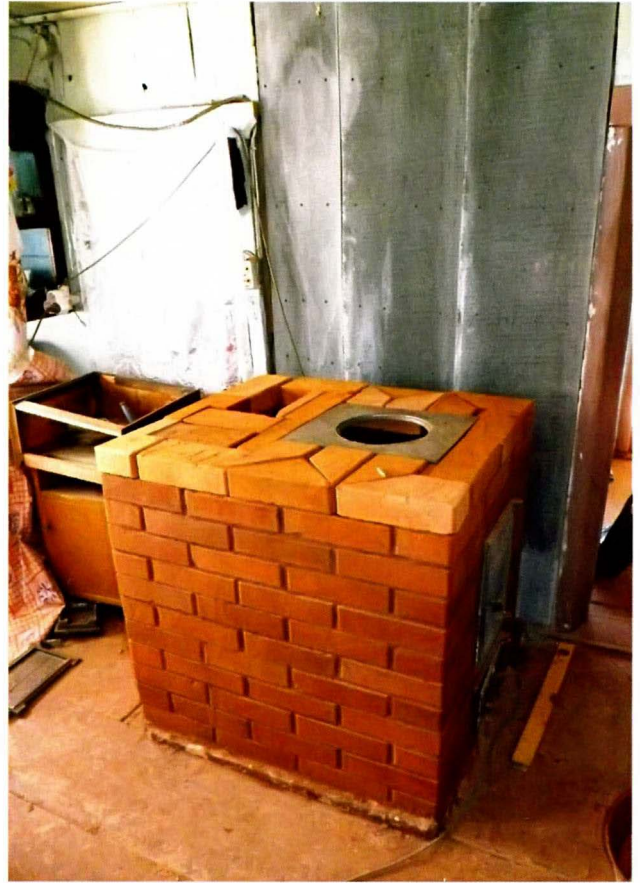
Установка одноконфорочной варочной плиты.
