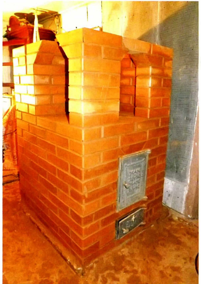
Перекрытие свода варочной камеры.
