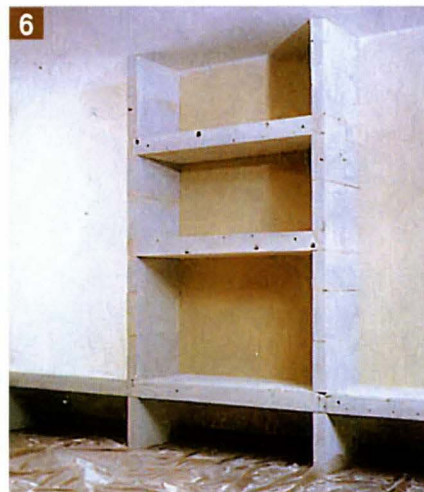
6 После того как каркас стеллажа будет готов, приступают к отделке его поверхностей.
