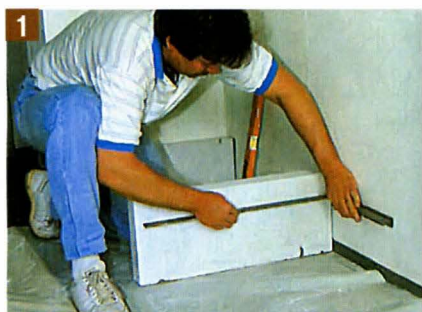
1 Положение каждого блока точно выверяют относительно стены. Все блоки кладут параллельно друг другу.
