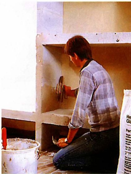
Перед покраской или оштукатуриванием поверхности газобетонных блоков тщательно зачищают и сметают с них пыль.
