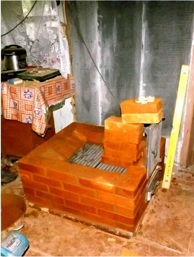
Установка топочной дверки.
