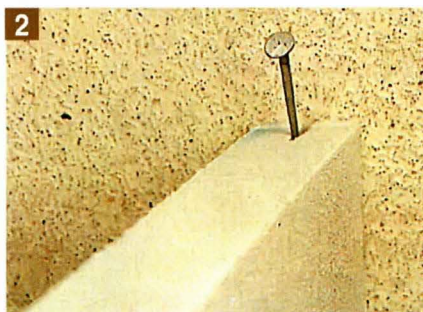
2 Чтобы кладка была устойчивой, каждый третий ряд блоков закрепляют гвоздём по газобетону.
