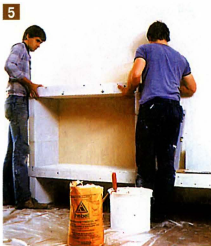
5 Полки лучше укладывать вдвоём, чтобы случайно не сместить уложенные и тщательно выверенные блоки.
