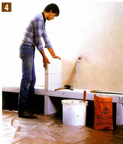
4 Кладку ведут, проверяя положение каждого блока уровнем как в горизонтальной, так и в вертикальной плоскостях.
