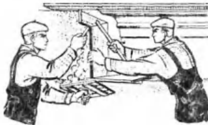
Рис. 48. Вытягивание карниза
