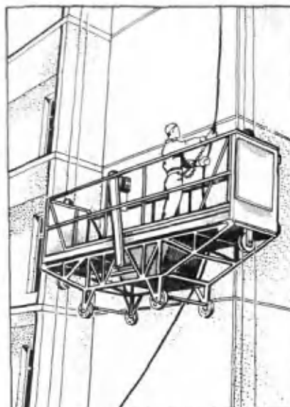
Рис. 8. Самоподъемная люлька ЛС-80-250
