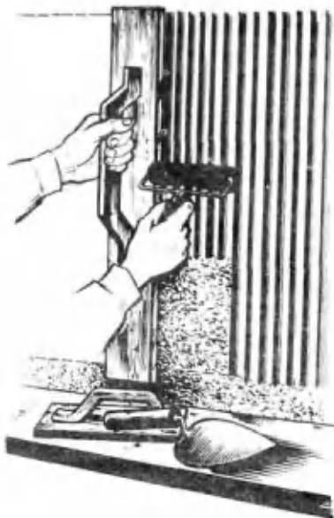
Рис. 128. Обработка штукатурки валиком
