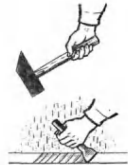
Рис. 132. Наковка штукатурки зубилом
