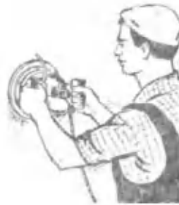
Рис. 43. Затирка штукатурки электрической машинкой
