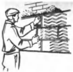
Рис. 61. Установка простых реек для устройства рустов
