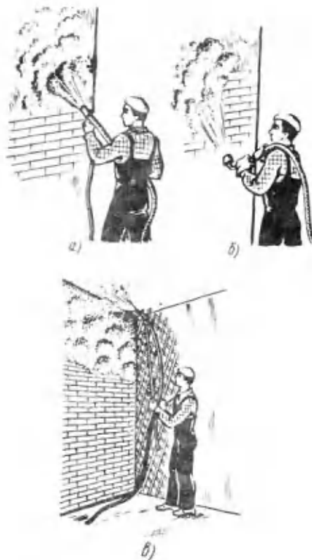
Рис. 41. Нанесение раствора на стену (а, б) и на потолок (в)
