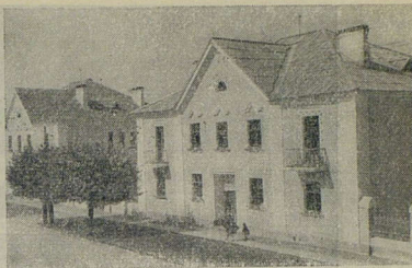
В этих новых удобных домах живут псковские строительные рабочие.
